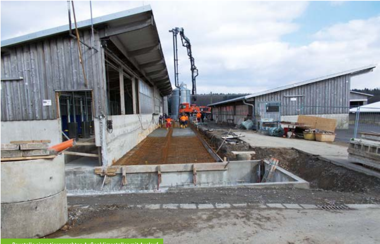
Baustelle eines tiergerechten Außenklimastalles mit Auslauf.
