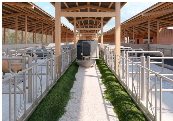
Futtertisch mit Roboter im Kompromissstall.
