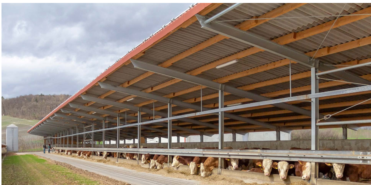
Einschichtiger Dachaufbau mit Trapezblechen.
