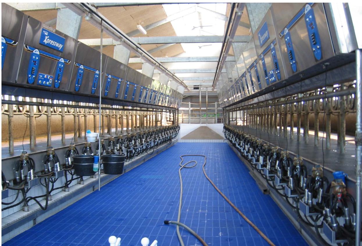
Eine breite Melkgrube benötigt zur richtigen Ausleuchtung der Arbeitsbereiche zwei Leuchtenreihen.
