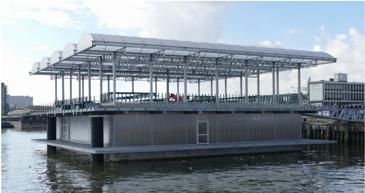
Beispiele für Gewebedächer: Hier die Floating Farm (schwimmender Stall) mit einem Gewebedach.
