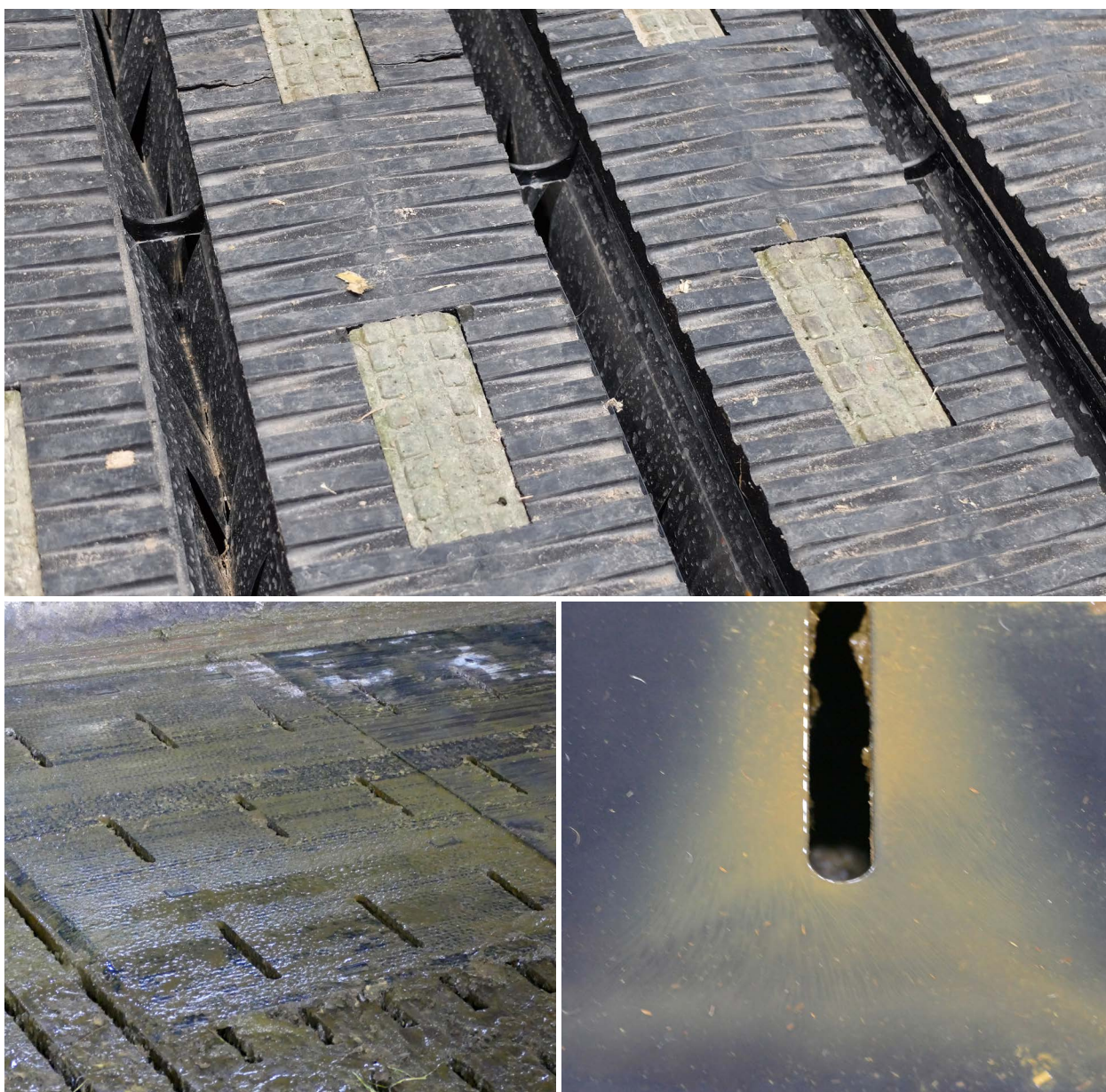
Durch spezielle emissionsreduzierende Gummiauflagen auf dem Spaltenboden wird ein Beitrag zur Verringerung der Emissionen geleistet.
