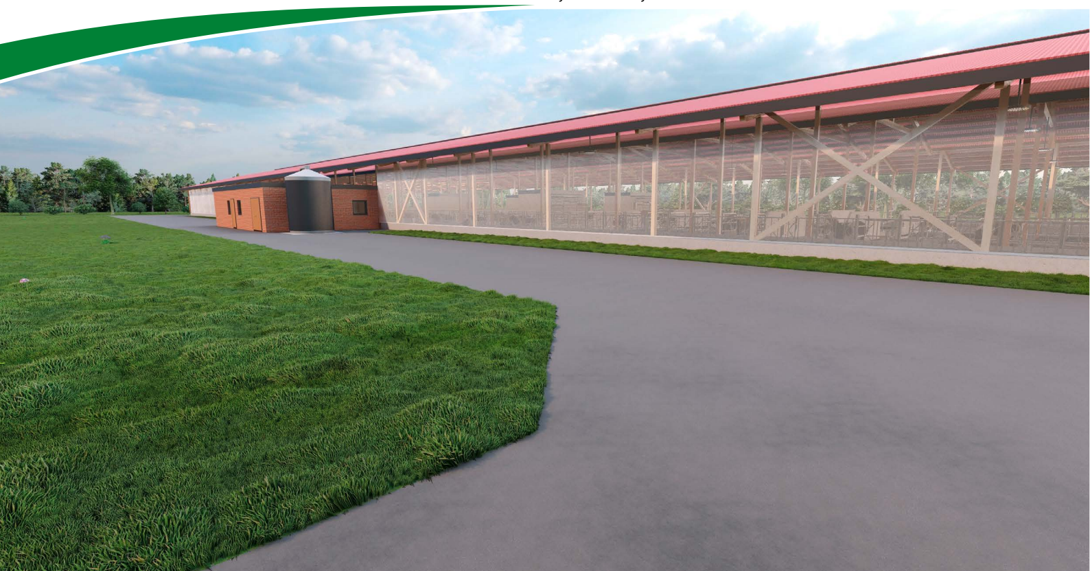
Außenansicht auf den Ökonomiestall.
