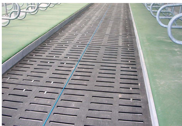
Mit einer zusätzlichen Gummiauflage auf dem Spaltenboden wird das Bewegungsverhalten der Kühe weiter aktiviert.
