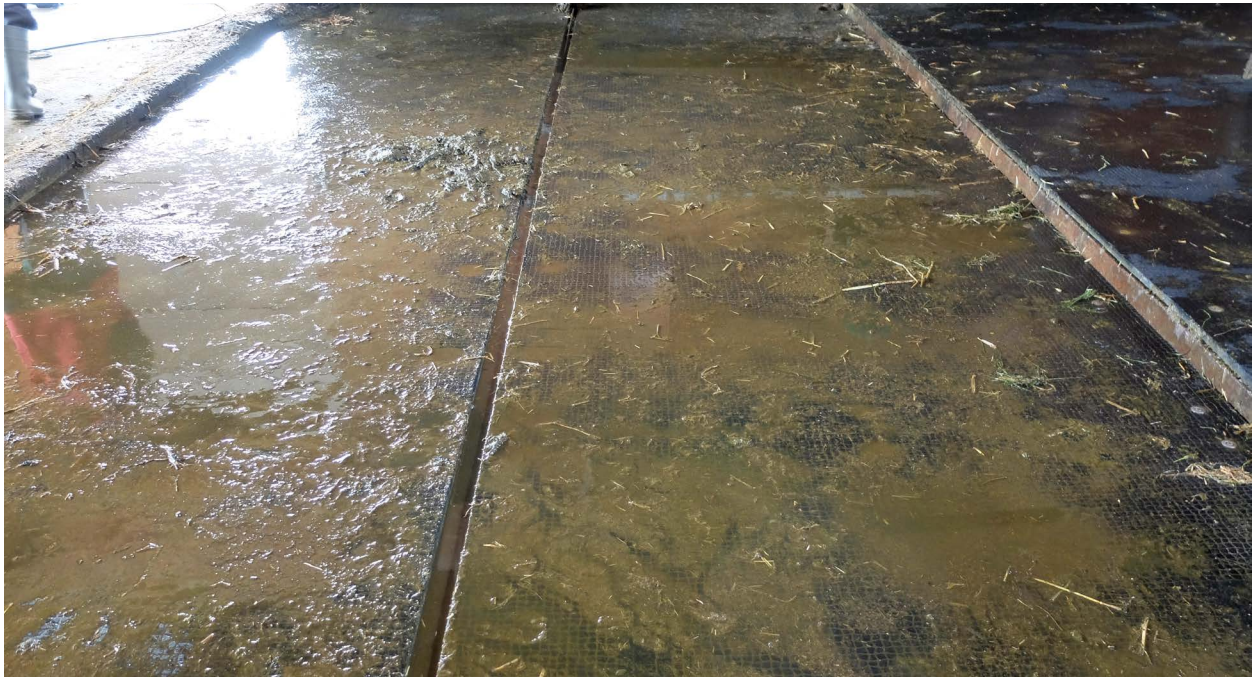
Planbefestigte Lauffläche mit Gummiauflage.
