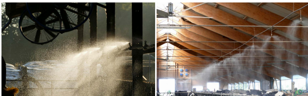
Niederdruckanlage/Sprinkler (links) und Hochdruck-/Verneblungsanlage (rechts).
