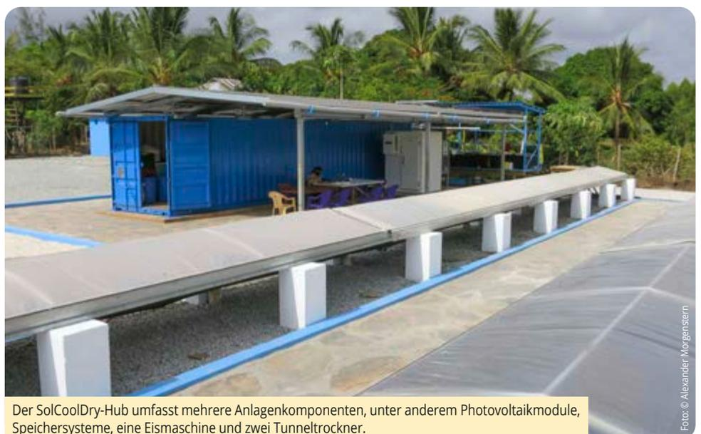
Der SolCoolDry-Hub umfasst mehrere Anlagenkomponenten, unter anderem Photovoltaikmodule, Speichersysteme, eine Eismaschine und zwei Tunneltrockner.
