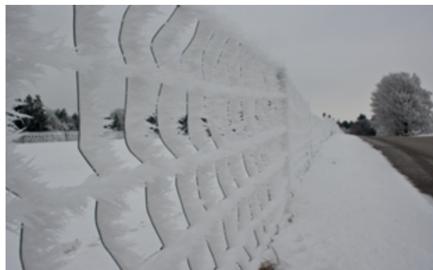
Im Winter kann durch Frost die Erdung und damit der Stromfluss durch den Zaun unterbrochen werden.
