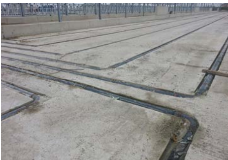
Abbildung 10: Im Kompostierungsställen werden Belüftungsrohre unter der Kompostmatte verlegt.
