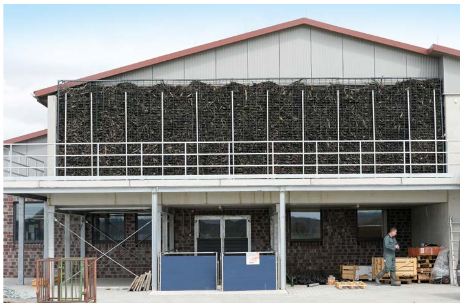
Abbildung 14: Die Reinigung der Abluft durch ein organisches Filtermaterial (obere Etage des Gebäudes) ist ein technisch aufwändiges und teures Verfahren, um Emissionen zu reduzieren.
