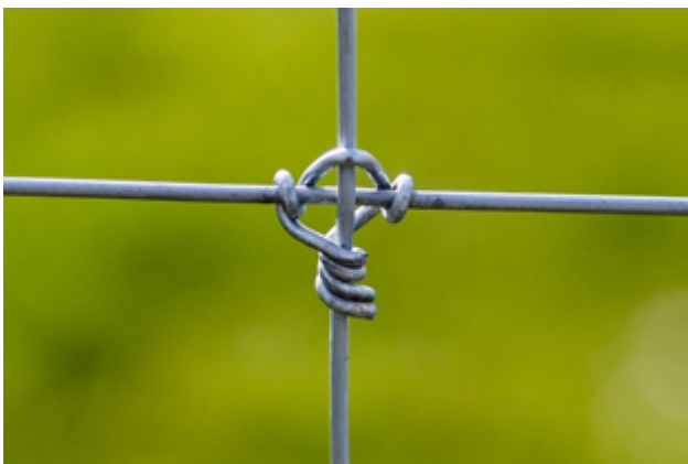
Für Gehegewild wird ein Zaun mit Knotengeflect empfohlen.
