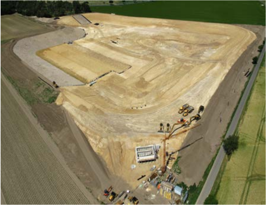
Abbildung 6: Der Wasserspeicher Borg mit 440.000 Kubikmetern des Bewässerungsverbands Uelzen speichert Wasser aus der Zuckerfabrik in Uelzen.
