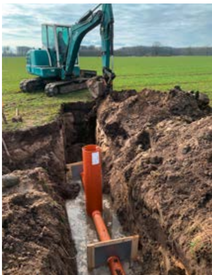
Abbildung 26: Anlage einer gesteuerten Drainage.
