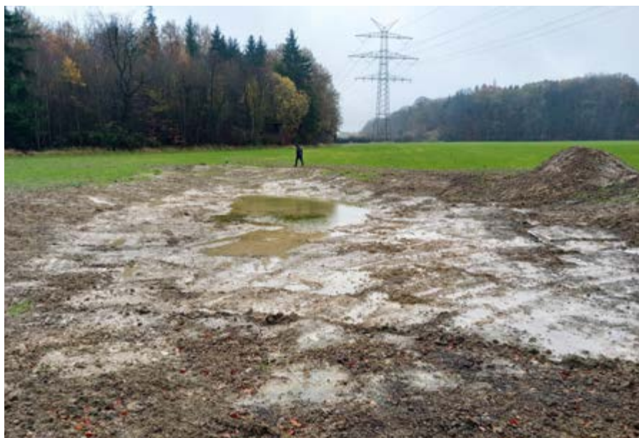
Abbildung 22: Anlage einer Rückhaltemulde, die das Oberflächenwasser der umgebenden Fläche aufnimmt, den unkontrollierten Abfluss verhindert und vor Überschwemmungen auf der Fläche schützt.
