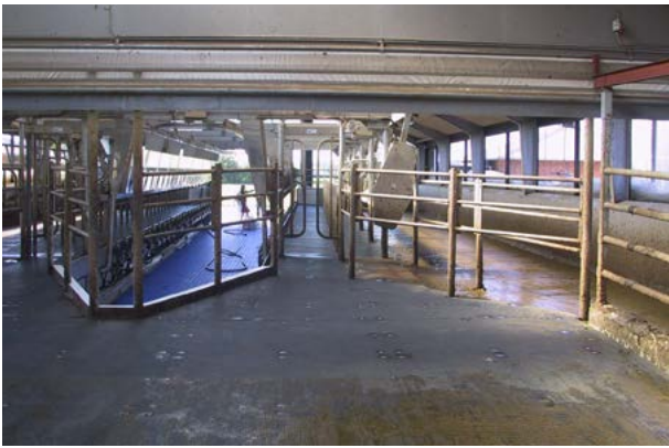
Wartebereich mit zu öffnenden Seitenwänden und einem trichterförmigen Zulauf.
