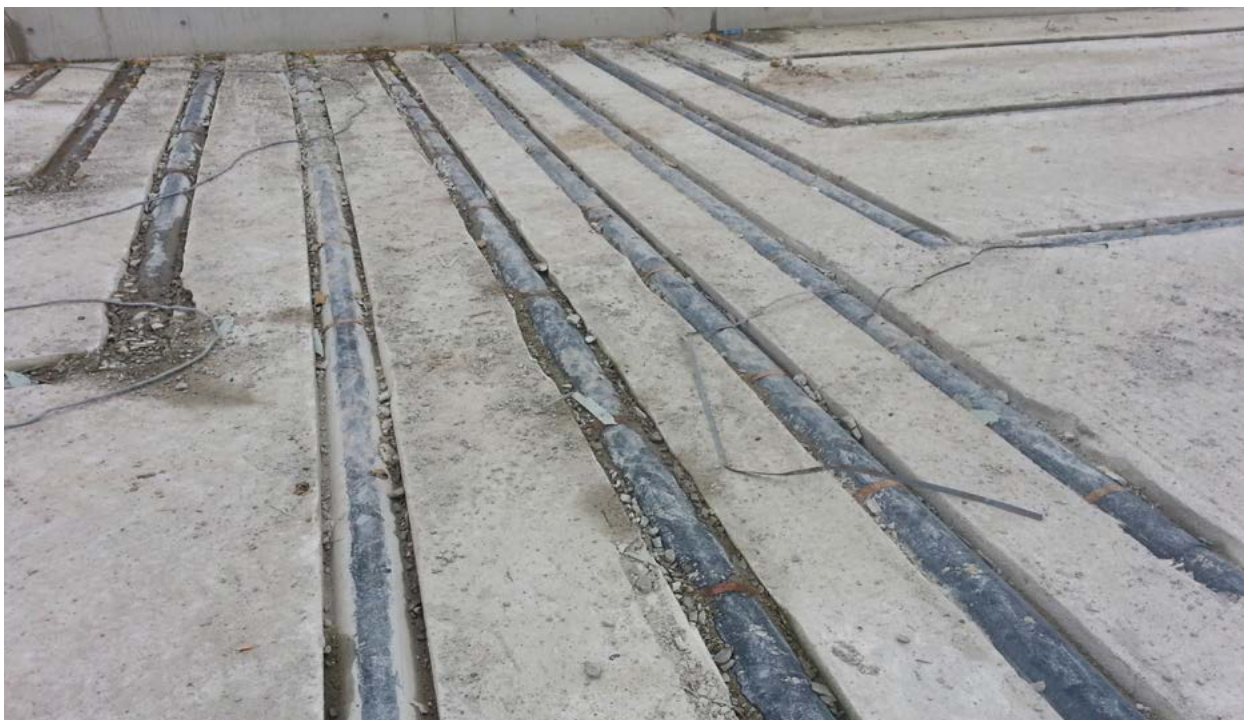
Die Belüftungsrohre befinden sich unter der Kompostmatte.
