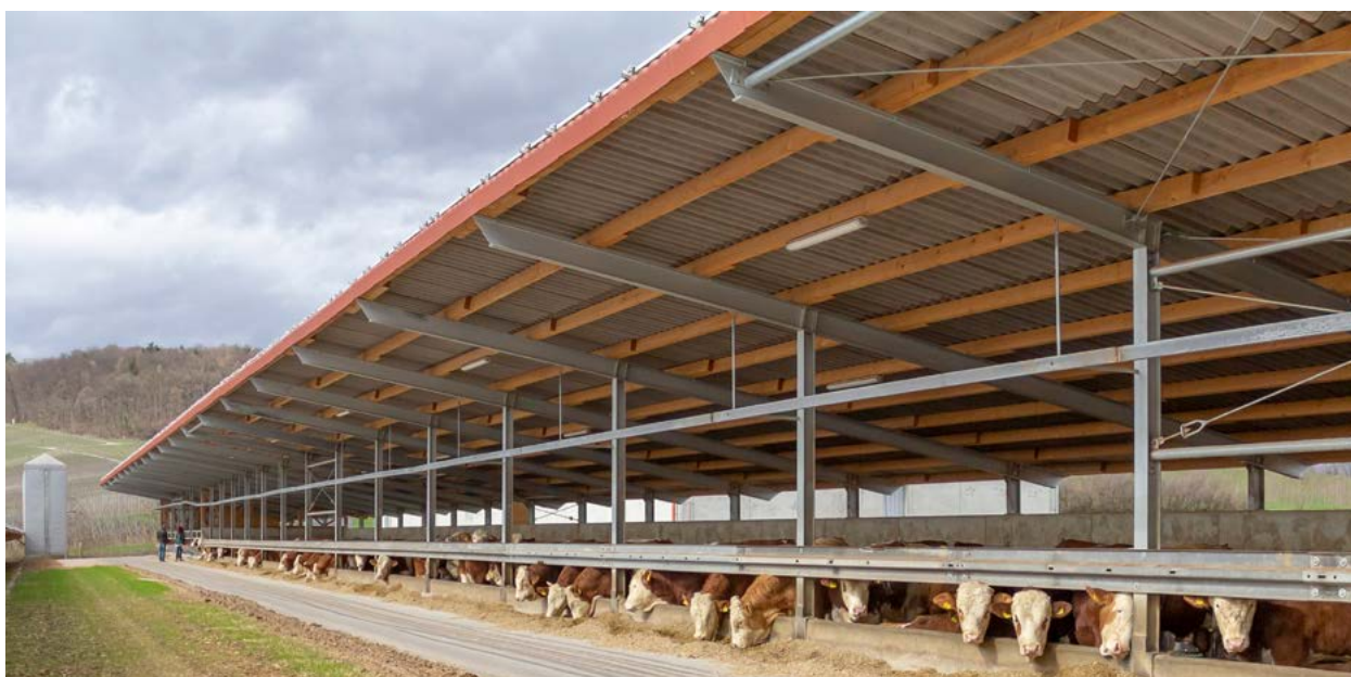
Einschichtiger Dachaufbau mit Trapezblechen.
