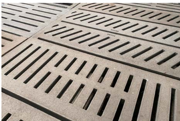
Bei Spaltenböden kann der abgesetzte Urin direkt ablaufen.
