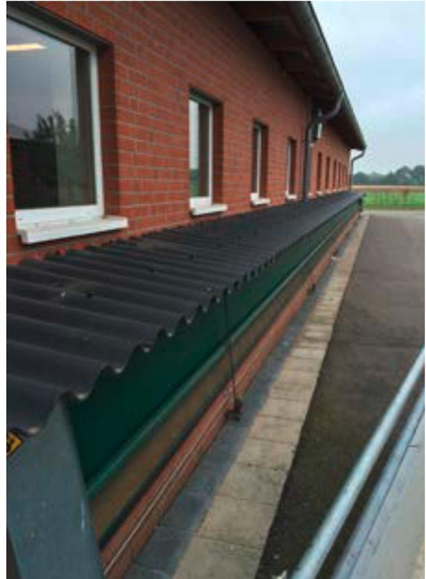
Bild 147: Zuluftöffnung zum Erdwärmetauscher
