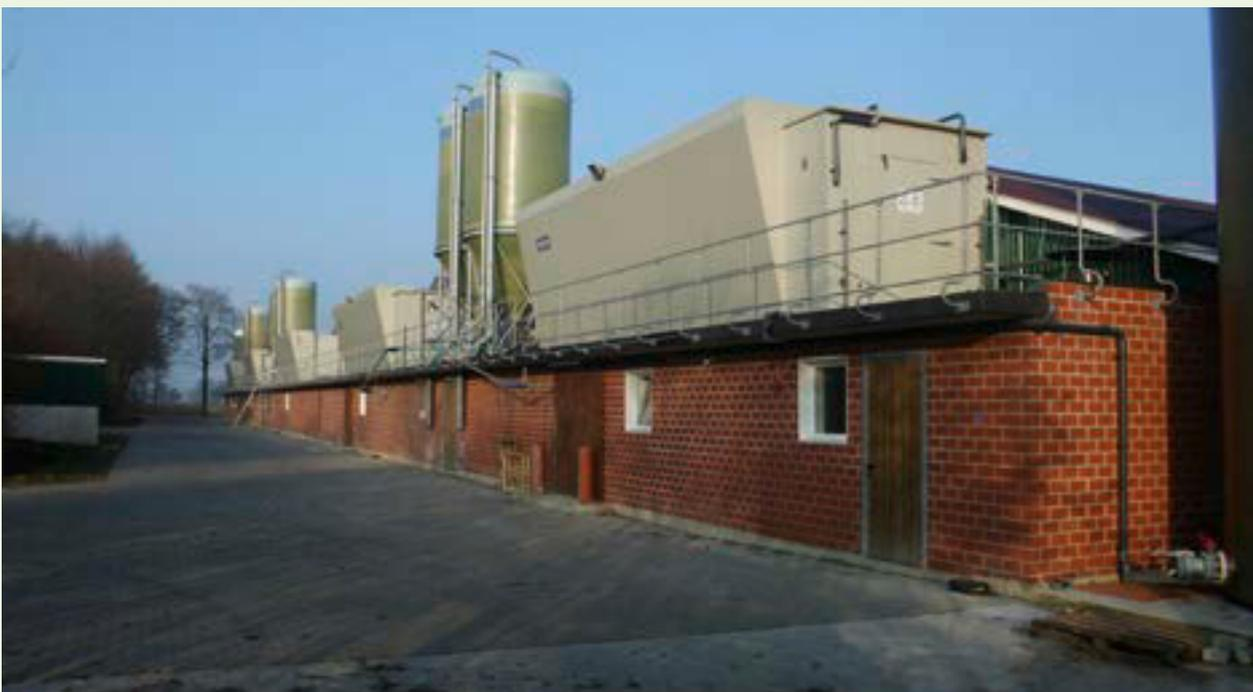
Bild 175: Abluftfilter können die Stallluft reinigen und so Emissionen mindern.
