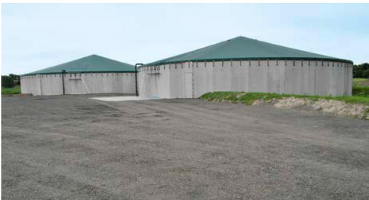
Bild 93: Die Methanbildung kann durch den Eintrag von Beschäftigungsfutter in die Gülle ansteigen, deshalb ist eine Güllelagerung außerhalb des Stalles mit Zeltdach vorteilhaft.
