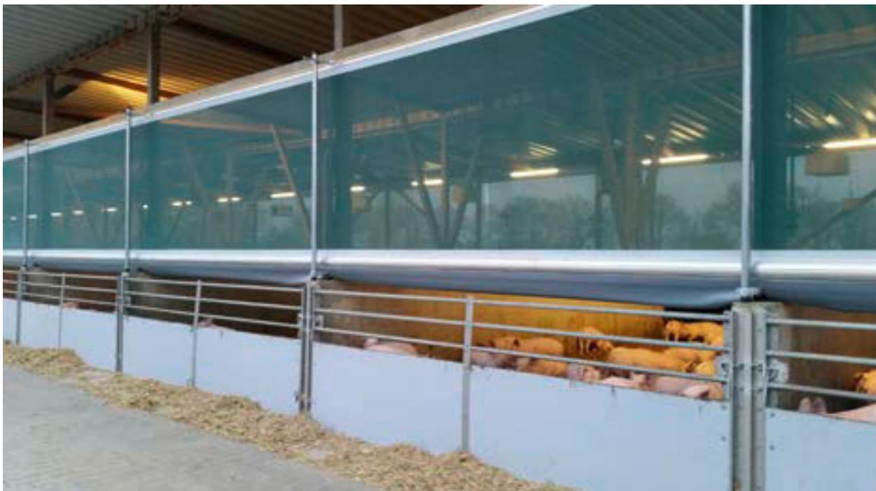
Bild 113: Offene Außenwände, Windbrechnetze, lassen Licht und Luft in den Stall.
