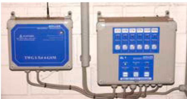
Bild 136: Alarmanlage, links Einwahl ins mobile Netz; rechts Steuerung der Lüftungsanlage
