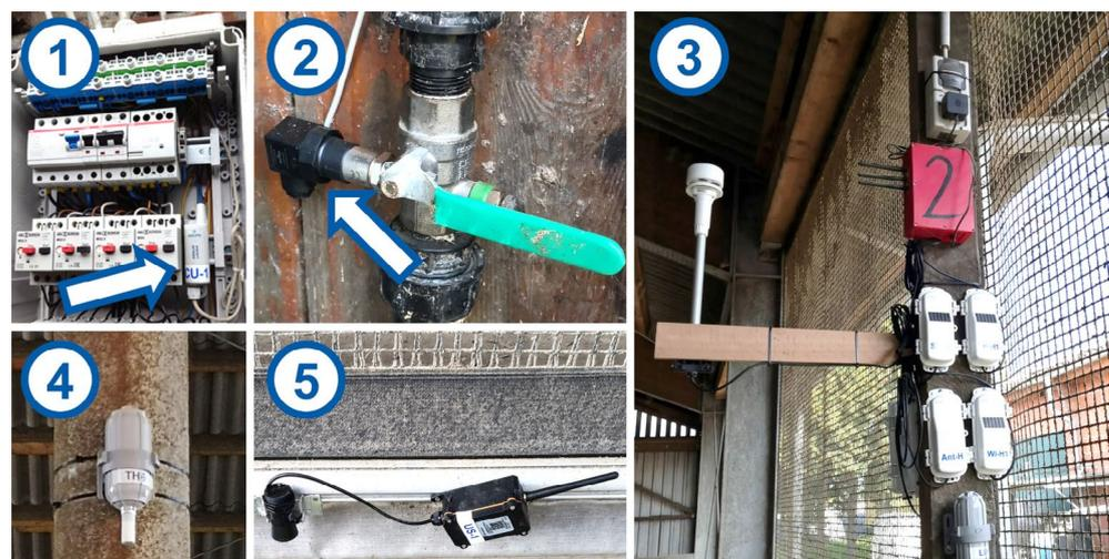
Abbildung 2: Einblick in die verbaute Sensorik. 1: Stromsensor (berührungsfreie Messung), 2: Wasserdrucksensor (Beregnung der Tiere im Vorwarte-hof an/aus), 3: verschiedene Stallklimasensoren (Wind, Sonneneinstrahlung, Temperatur/Luftfeuchte), 4: Temperatur-Luftfeuchte-Sensor, 5: Curtain-Sensor (offen/geschlossen) (© Wille Engineering).
