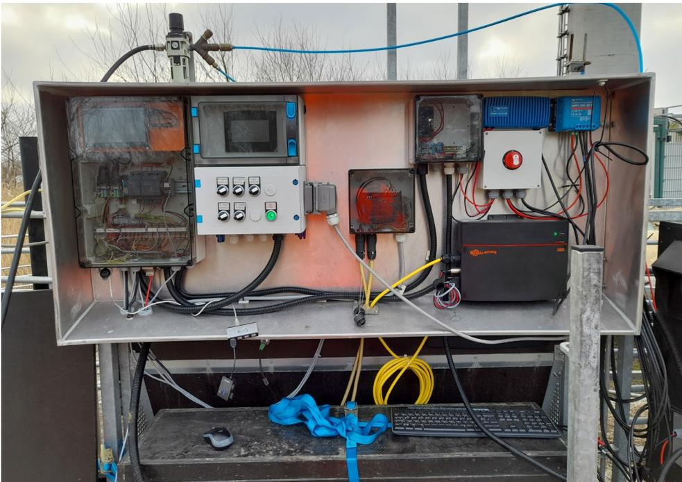
Abbildung 2: Technische Ausrüstung im Aluminiumkasten: (v. l. n. r.) Software & automatische Steuerung, manuelle Steuerung, DMS-Verstärker, Spannungsanzeige, Ohrmarkenlesegerät, Ladegerät, Notschalter, Solar-Laderegler (© Hendrik Jasper).
