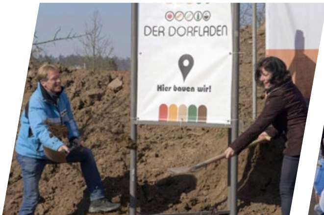
Spatenstich für den Dorfladen Schönstadt
