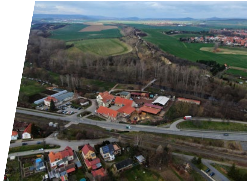
Die Marienbrücke verbindet den Hof mit dem Naturschutzgebiet Teufelsmauer und öffnet ihn dadurch für Wandertouristen.
