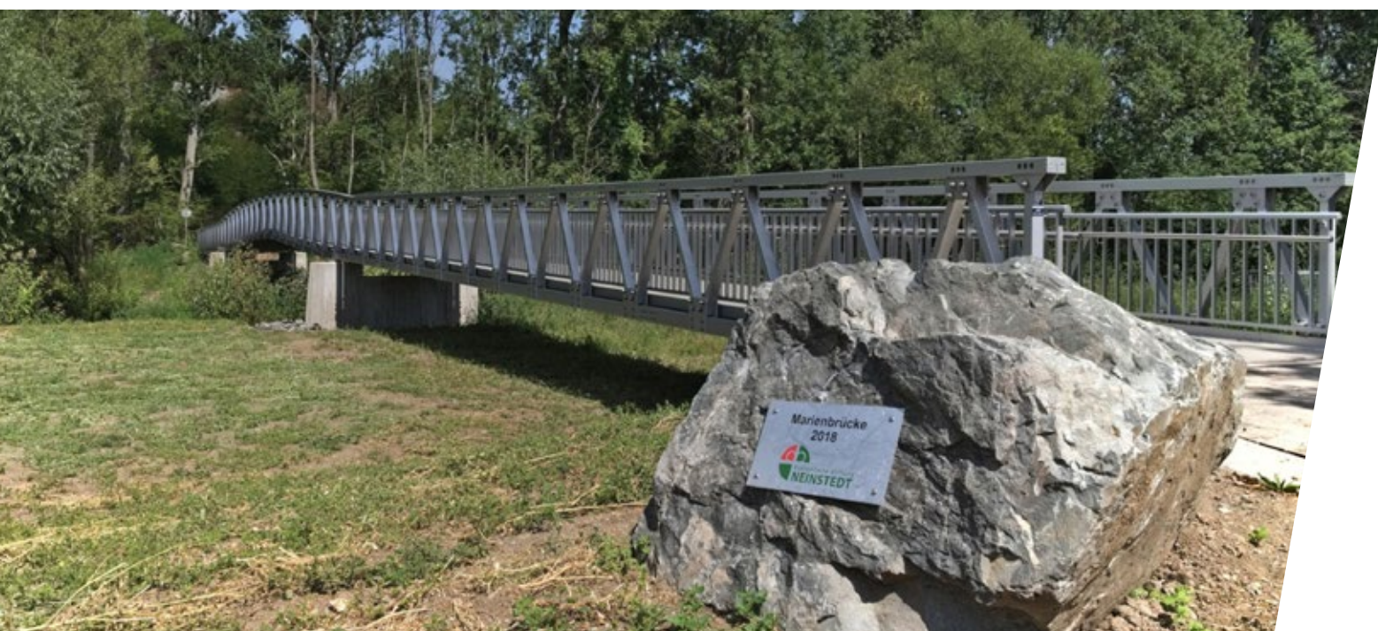
Eine neue barrierefreie Fußgängerbrücke hat den Marienhof im Harz als inklusiven, generationenübergreifenden Treffpunkt gestärkt.
