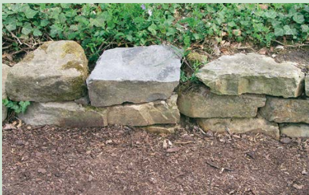
niedrige, lose aufgeschichtete Mauer
